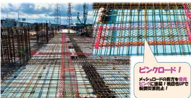
建設現場での転倒災害防止対策(例)
